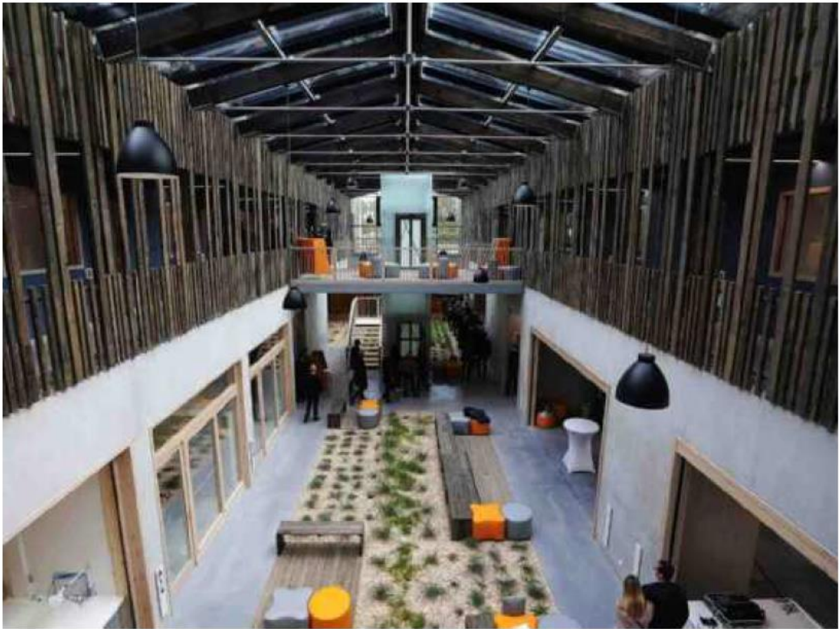
Le hall central de l'Agrocampus, dont l'atrium biodynamique joue sur l'inertie de la terre pour assurer chauffage et aération. PHOTO PASCAL BATS/« SUD OUEST »
